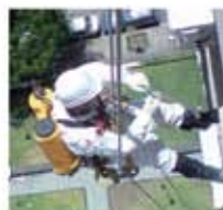
Trabajos en altura
